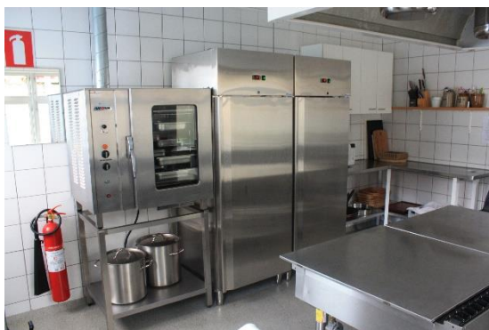
120 l varmluftovn, 2 køleskabe, i midten 8 kogeplader til gas.
